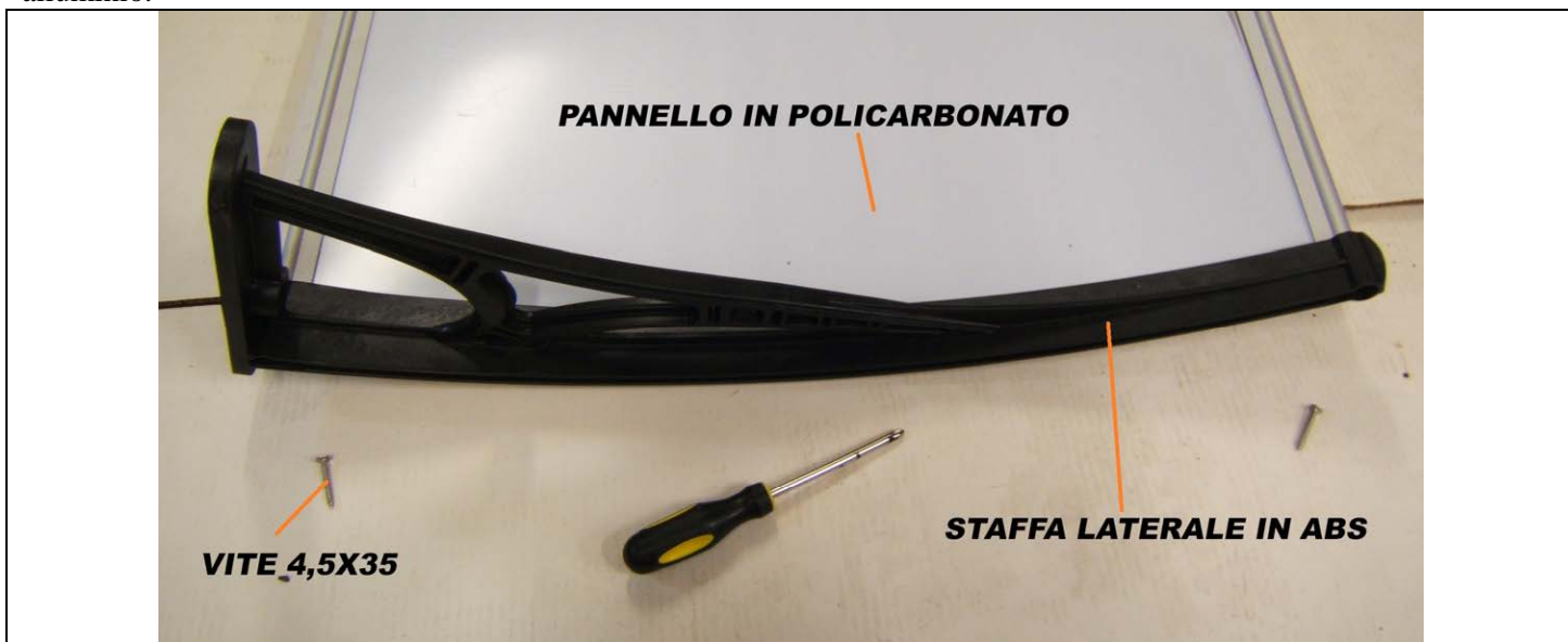
Fig.5: Inserimento staffe laterali
